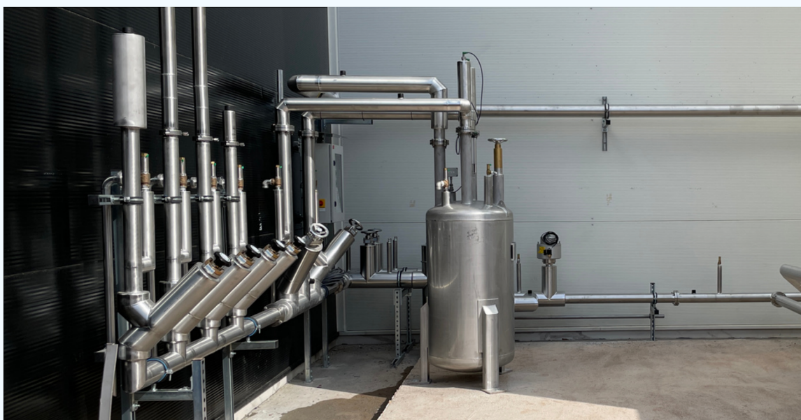
Voorbeeld van cryogene leidingsystemen
